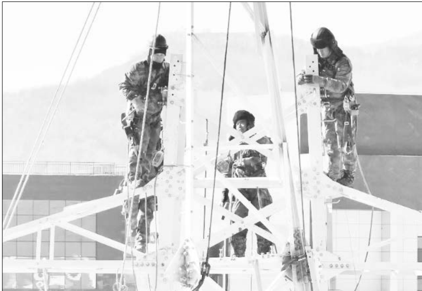
영길현 영개 66 키로볼트 송전선로탑 조립 현장
