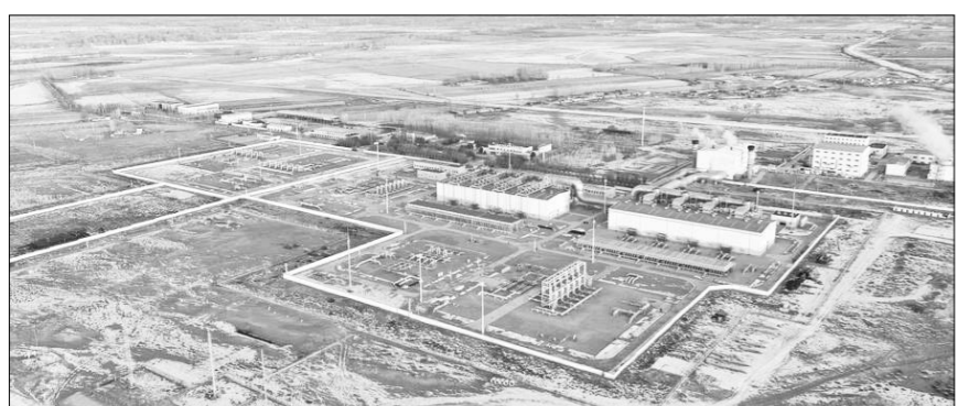
2021년 2월 4일, 신강 휘얼귀스에 위치한 중국 국가석유천연가스관망그룹 산하 서부도관회사의 휘얼귀스 가스압축소. (드론사진) / 신화넷
