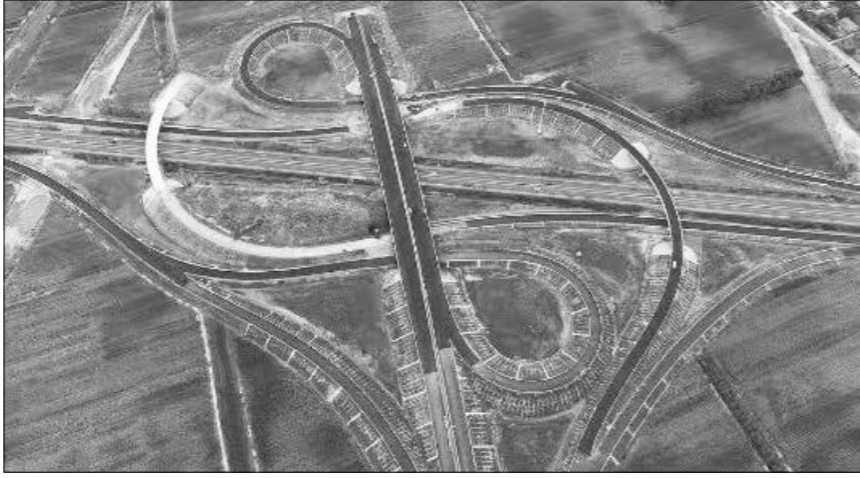
이미 마무리된 장춘 도시권 순환 고속도로 2기 K1+500 농안현 지가(迟家) 허브 공사
