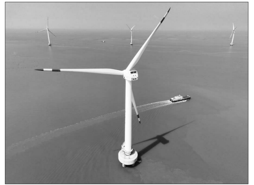
북건설 북청시에 위치한 삼협 북청 흥화만 해상풍력발전소 (드론사진) / 신화넷
